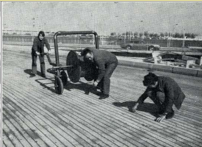
1968, Installation des Heizbandes auf einer Zufahrtsrampe zu einem Busparkplatz, Flughafen Orly bei Paris (Elektrische Fußbodenheizung, von Robert Félix, 1971, Ultimheat Museum*)
